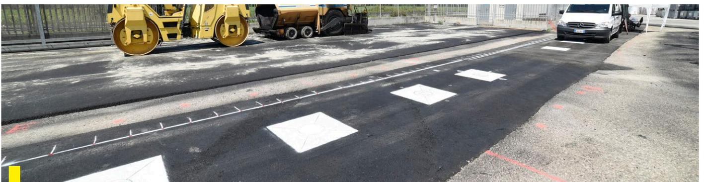
Mappatura del tronco pilota con marcatura dei vari **punti di prova**
