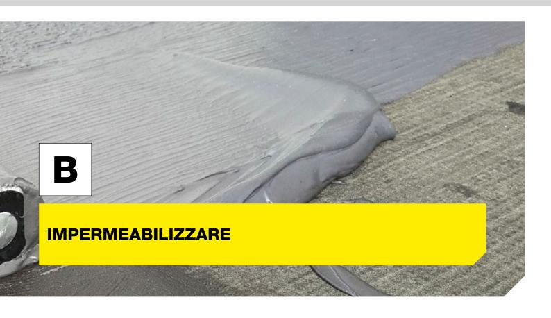
Le membrane liquide (LAM) a base acqua o a base solvente, bituminose o acriliche, sono degli ottimi rivestimenti elastomerici in grado di impermeabilizzare e proteggere superfici in calcestruzzo, legno e metallo. Le membrane liquide Copernit sono particolarmente indicate per impermeabilizzare balconi e/o terrazze e ripristinare e/o riparare vecchie membrane bituminose.
