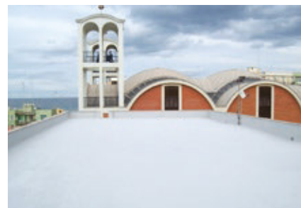
Impermeabilizzazione su chianche. Chiesa di Molfetta
